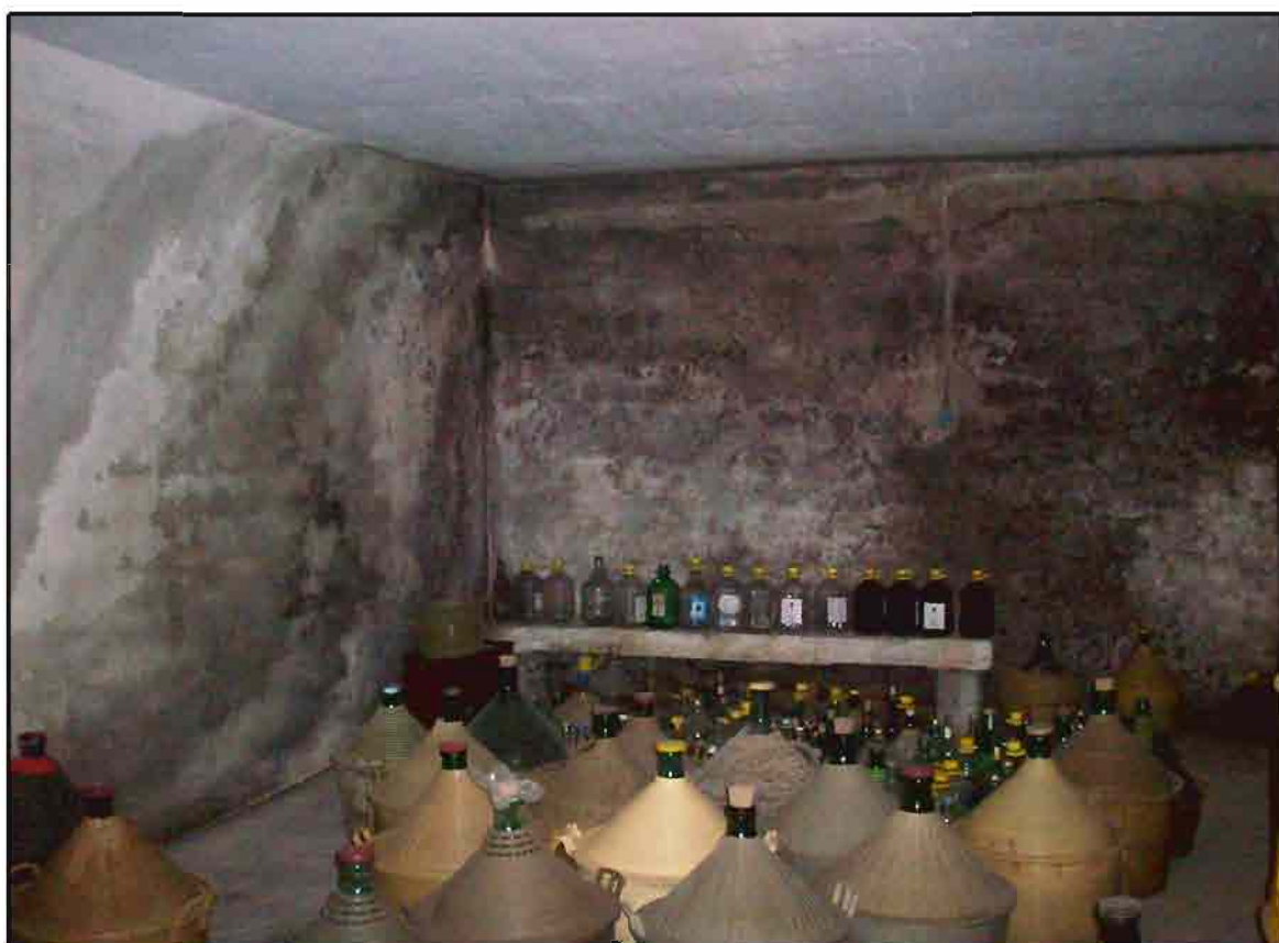
FOTO 4 : Interno del locale cantina posto al piano interrato del fabbricato esecutato.
