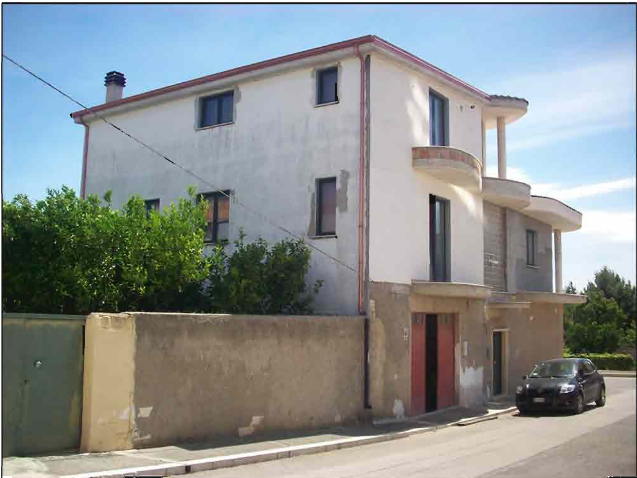
FOTO 2: Accessi da via Palazzina, 62 (ex Via Unità d'Italia)
